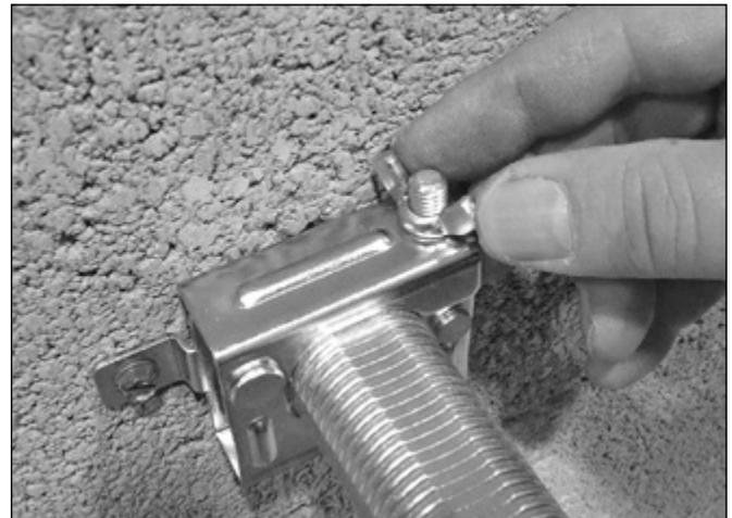
4. Schieben Sie den Sprinklerreduzierenippel in die mittige Öffnung der Baugruppe und durch das Loch in der Wand oder Decke. Stellen Sie sicher, dass die Biegungen des flexiblen Schlauchs die in dieser Montageanleitung aufgeführten Anforderungen erfüllen
