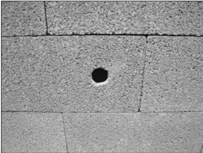
1. Bohren Sie an der gewünschten Stelle ein Loch in die Wand oder Decke. Siehe die Montageanleitung des Sprinklerherstellers zur Größe des Lochs.
