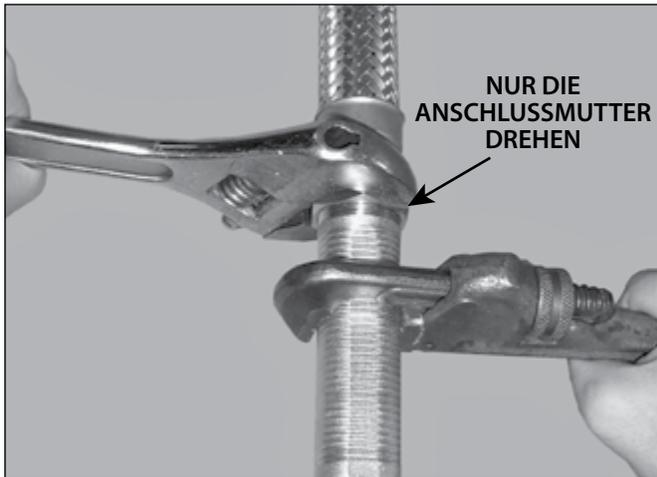
3. Stellen Sie vor der Montage sicher, dass die Dichtung in der Mutter des flexiblen Schlauchs richtig positioniert und nicht beschädigt ist. Bringen Sie die Mutter am Reduziernippel des Sprinklers an.
